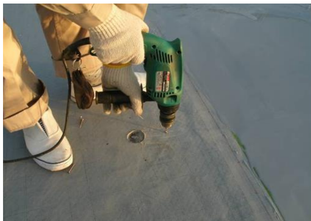
3 振動ドリル(φ4.5mm)でビス穴を開ける
