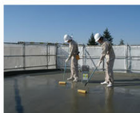
▲ プライマーを塗布して下地を強化する
