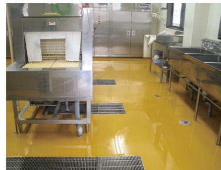
施工例①：厨房床
